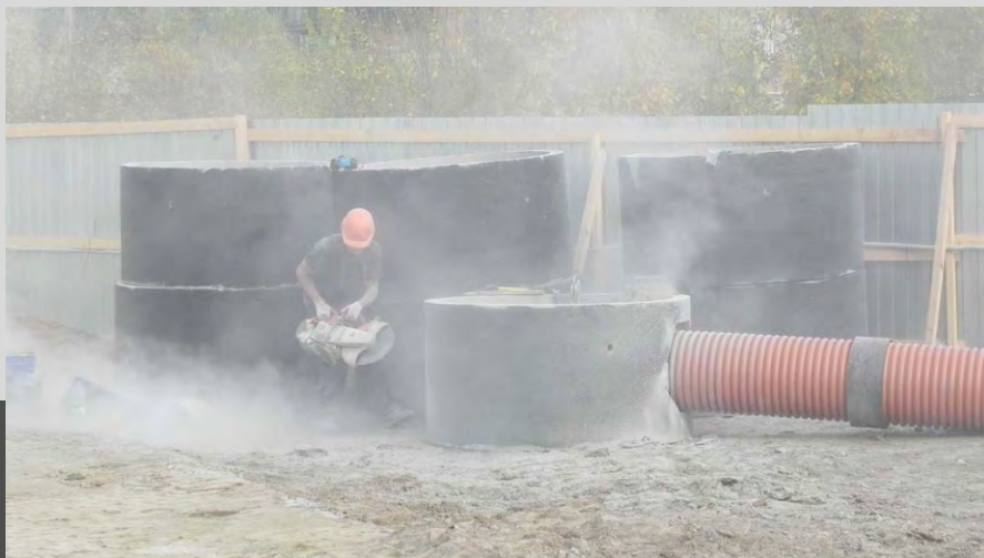
Монтаж магистральных инженерных сетей осуществлялся до строительства и реконструкции автомобильных дорог. Фотографии процесса монтажа сетей по ул. Центральной 2015-2016 гг.
