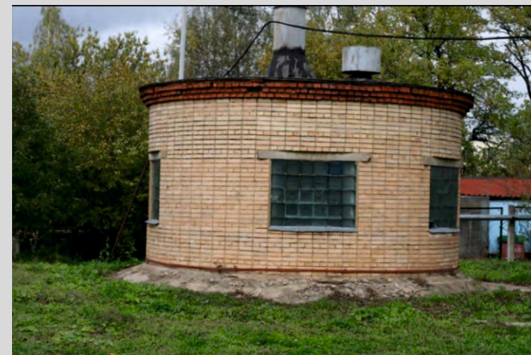
Существующее сооружение, фото из отчета 2015 г.
